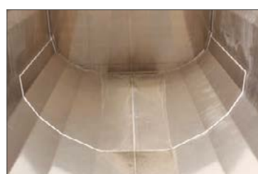
Aluminium-Verschleißboden im hinteren Bereich
