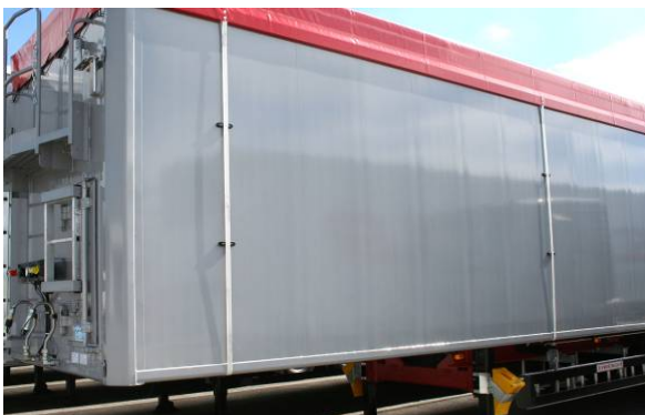
Seitenwand innen und außen: Schweißnähte auf Risse prüfen
