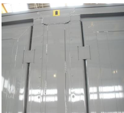
Mittelsäulen: Nieten auf Festsitz prüfen, Scharniere auf ordnungsgemäße Funktion und Beschädigungen prüfen, Scharnierbefestigung auf Beschädigungen und Festsitz prüfen
