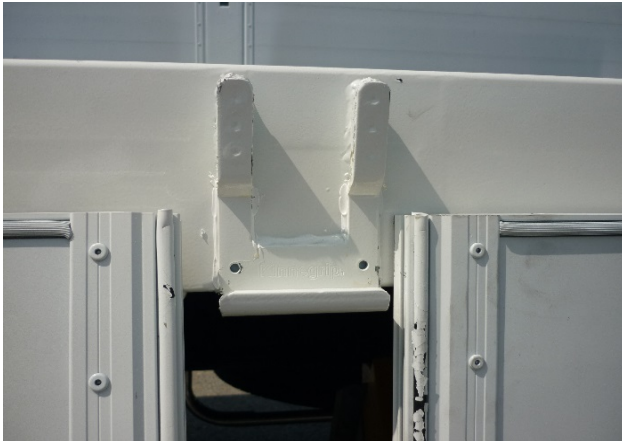
Rungenlager: Schweißnähte auf Risse prüfen
