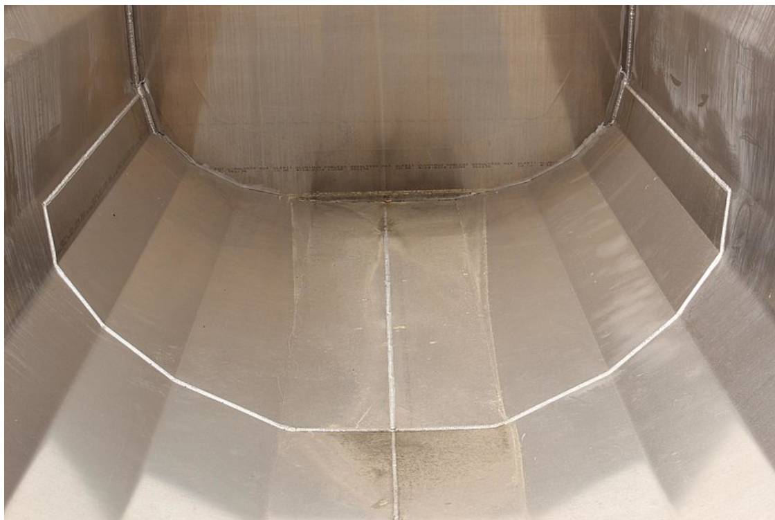
Aluminiowe dno ścieralne w tylnej części ok. 3 500 mm od końca zsypu
