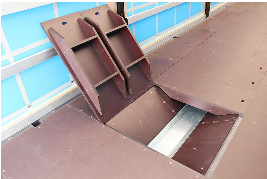
Osłona wgłębienia, po której można jeździć wózkiem widłowym, ze sklejki wodoodpornej 27 mm z podciągami
