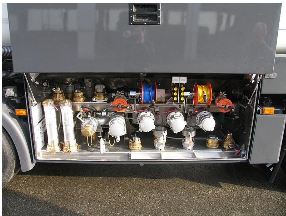
Szafka na armaturę z równoległe poprowadzonymi drzwiami szafki
