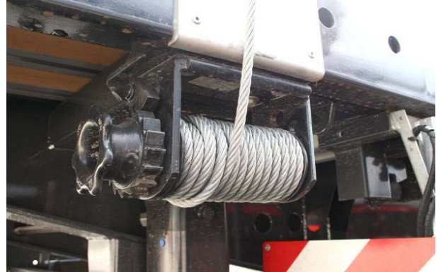
Seilspannrollen: Auf Funktion und ordnungsgemäße Befestigung prüfen
