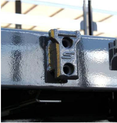
Rungenlager: Schweißnähte auf Risse prüfen
