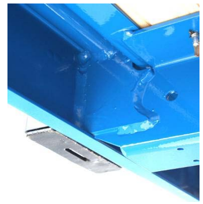
Rungenlager innen: Schweißnähte auf Risse prüfen
