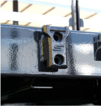
Rungenlager: Schweißnähte auf Risse prüfen
