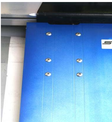
Ecksäulen hinten: Nieten auf Festsitz prüfen
