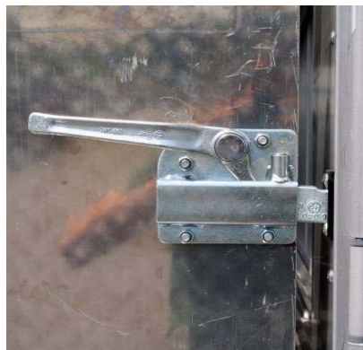
Alle Nieten und Schrauben der Verschlüsse und Verschlussaufnahmen auf Festsitz prüfen
