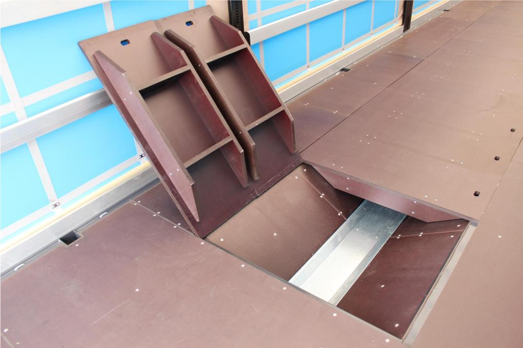
Staplerbefahrbare Muldenabdeckung aus 27 mm Siebdruckplatte mit Unterzug
