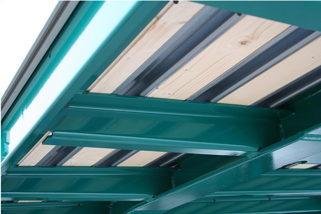
Doppelboden bestehend aus Stammboden mit integrierten Stahl-Omeegaschienen und darüber mit Siebdruck-Verschleißboden (Staplerachslast 5.460 kg)
