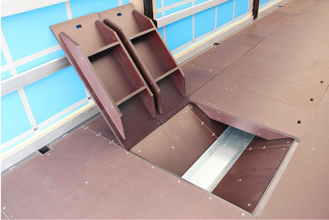
Staplerbefahrbare Muldenabdeckung aus 27 mm Siebdruckplatte mit Unterzug
