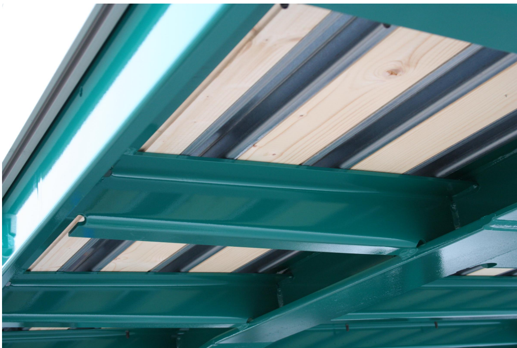
Tuhý žebřinový rám ocelové svařované konstrukce
