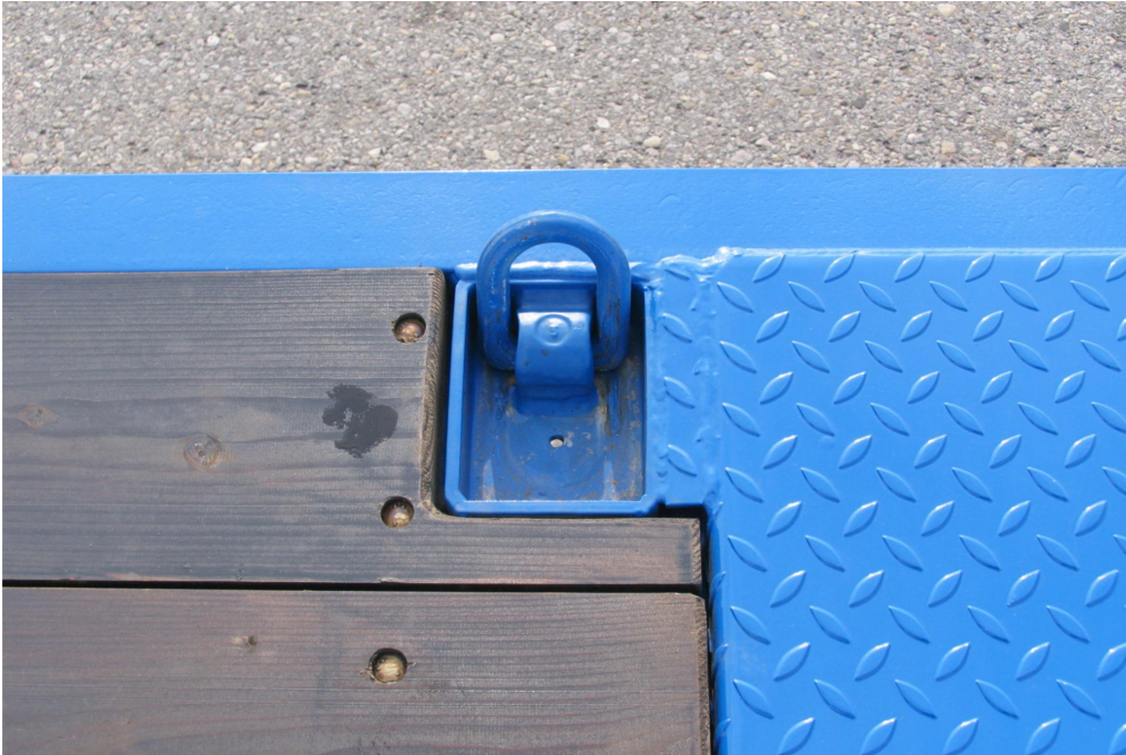
2 páry zapuštěných podlahových kotevních na plošině
